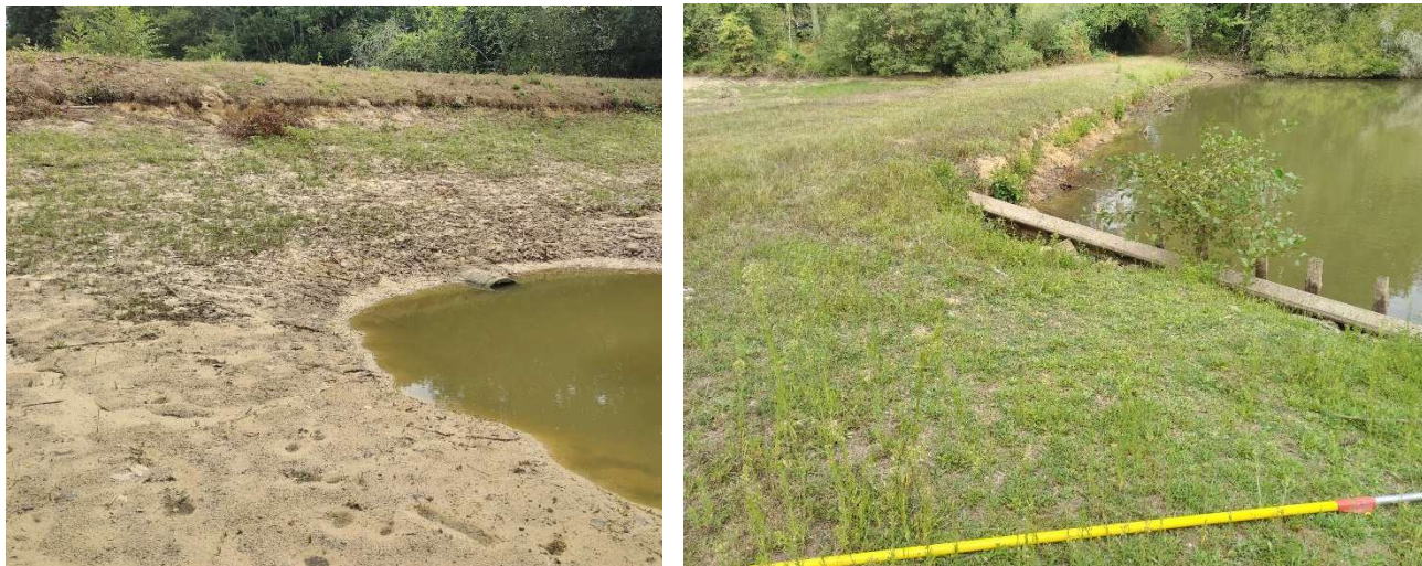
Figure 15 : Marche d'érosion sur les parements de la digue amont du barrage d'Arthez
