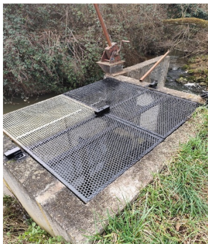
Figure 2 : Réparation des caillebotis de la station de réalimentation d'Arthez
