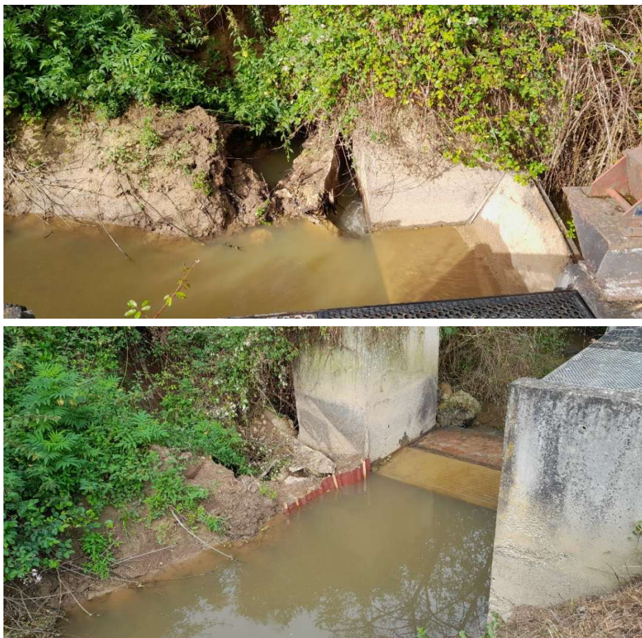
Figure 3 : Contournement du seuil rive gauche et réparation temporaire
