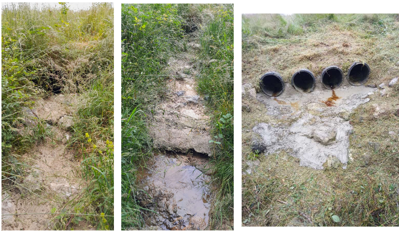
Figure 4 : Réparation du radier aval aux buses de l'évacuateur de crues (avant : 2 premières photos ; après : dernière photo)
