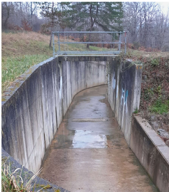
Figure 22 : Suintement en amont du dalot de l'évacuateur de crues du barrage de Coudures
