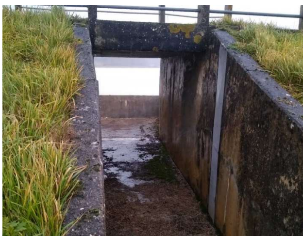
Figure 24 : Fissures en rive droite et rive gauche des bajoyers aval du dalot du barrage de Lapeyrie
