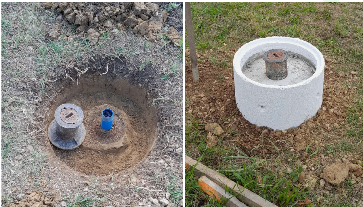
Figure 5 : Reprise d'une des têtes de piézomètres du barrage de Lapeyrie
