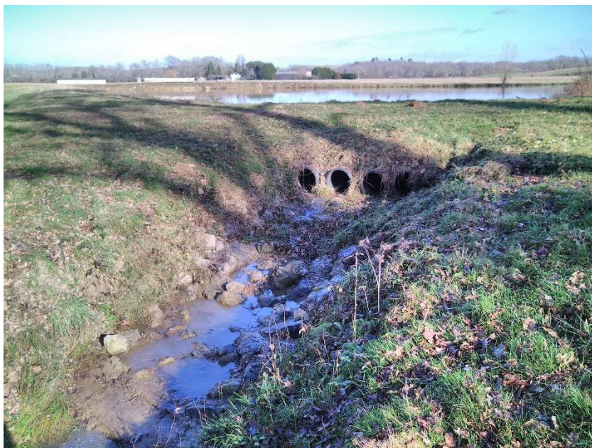
Figure 17 : Evacuateur de crues du barrage de Bougnères le 7 janvier 2022 après déversement du barrage
