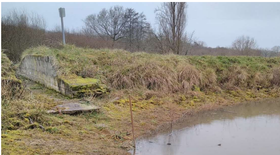
Figure 18 : Vue du parement amont et de l'érosion sous l'évacuateur de crues
